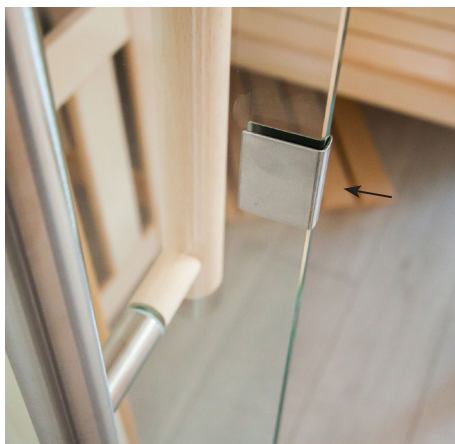
Kunststoff Beilagscheibe bei Niro-Griff beilegen
