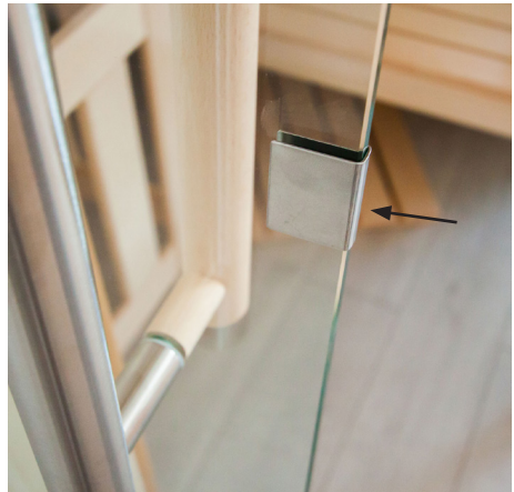
Kunststoff Beilagscheibe bei Niro-Griff beilegen
