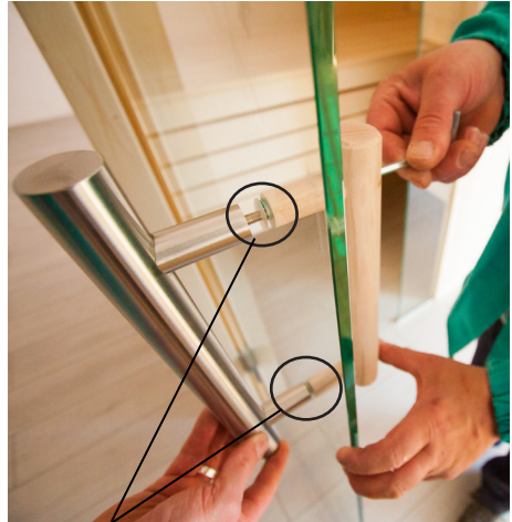
Kunststoff Beilagscheibe bei Niro-Griff beilegen
